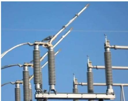
Figura 10.6. Seccionador de apertura vertical de operación tripolar.
