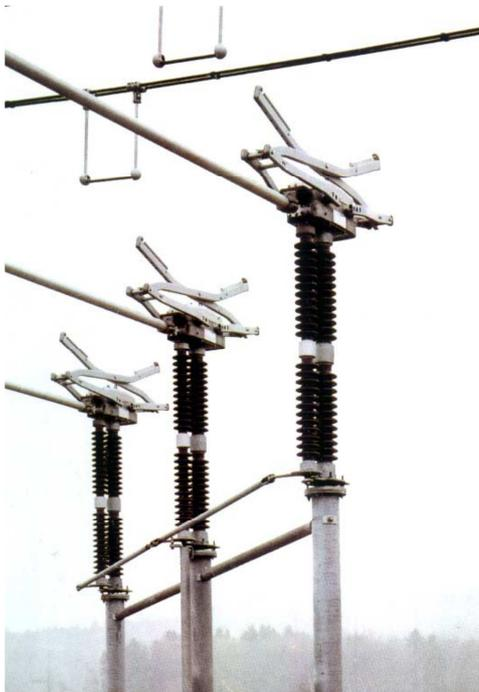
Figura.10.8. Seccionador pantógrafo de operación tripolar.
