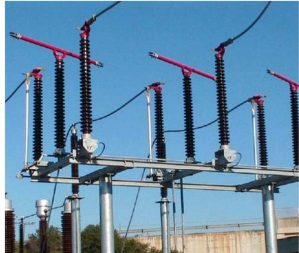
Figura 10.4. Seccionador de rotación central.
