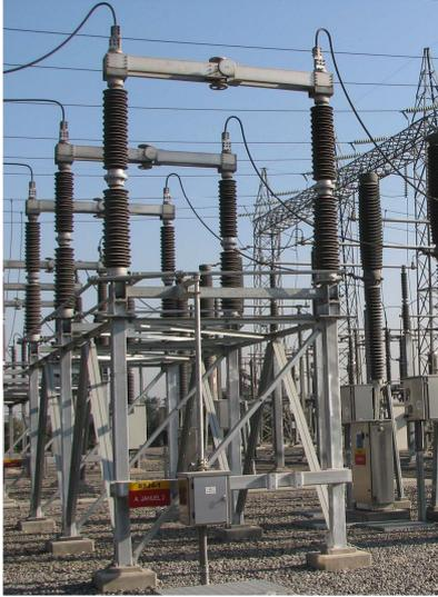
Figura 10.3. Seccionador de apertura central de operación tripolar.
